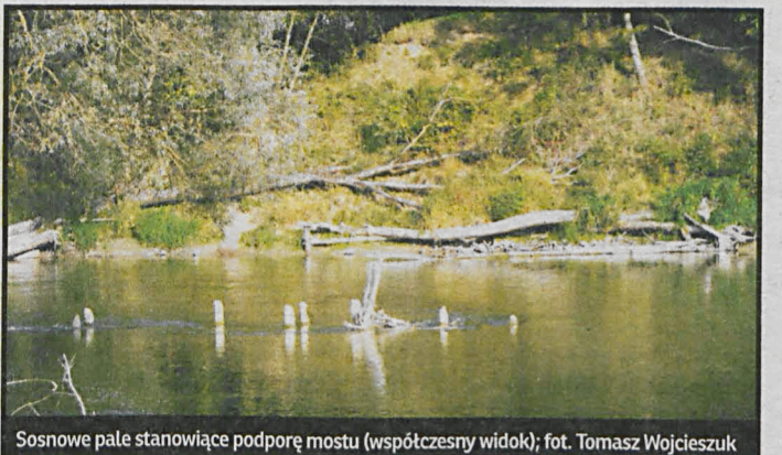
Sosnowe pale stanowiące podporę mostu (współczesny widok); fot. Tomasz Wojcieszuk
