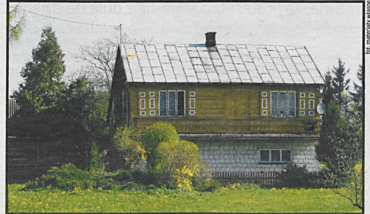
Rzadki – choć coraz częstszy – widok na Podlasiu: drewniana chata ustawiona na nowej podmurówce. „Tu mieszkali moi pradziadkowie, tu się wychowałem, tu chciałbym doczekać się swoich wnuków” – mówią ci, którzy podjęli trud remontu i konserwacji wiekowych domów
