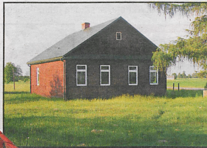
Cegła pochodząca z rozbiórki zabudowań dworskich posłużyła w 1916 r. mieszkańcy Kodnia Mikołajowi Lichaczewskiemu do budowy nowego domu przy ul. Białskiej (stan dzisiejszy)
