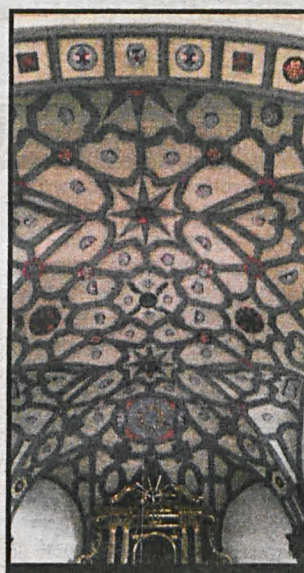
Stiukowe sklepienie prezbiterium kościoła św. Stanisława w Czemiernikach
