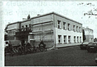
Budynek ZSO Nr 1 w Terespolu – część termomodernizowana
