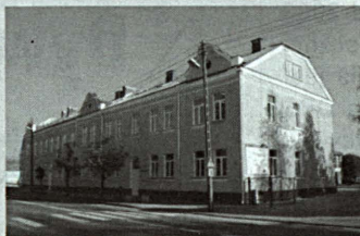
Budynek LO w Międzyrzeczu Podlaskim – nowa elewacja
