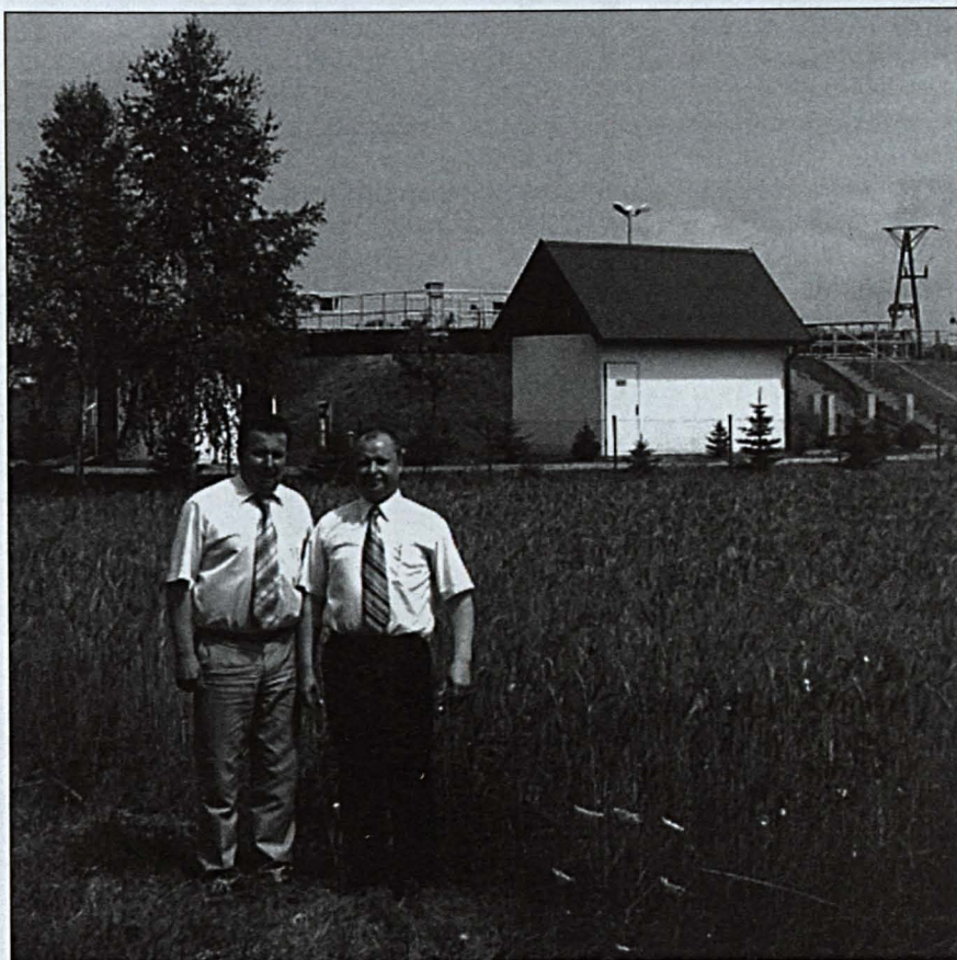
Starosta Tadeusz Łazowski i wójt Jacek Hura przed oczyszczalnią ścieków
