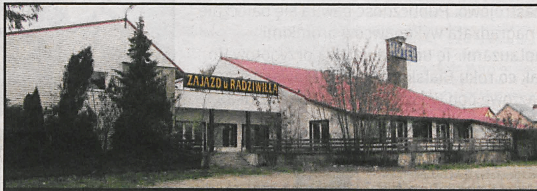
W miejscu, na którym stoi kwalifikujący się do rozbiórki Zajazd, ma powstać centrum dla dzieci autystycznych
