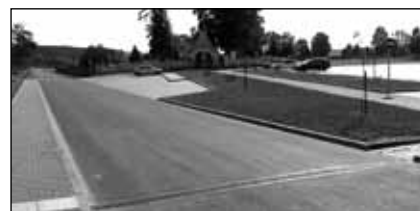
Przebudowa ulicy Bakaliowej w Janowie Podlaskim
