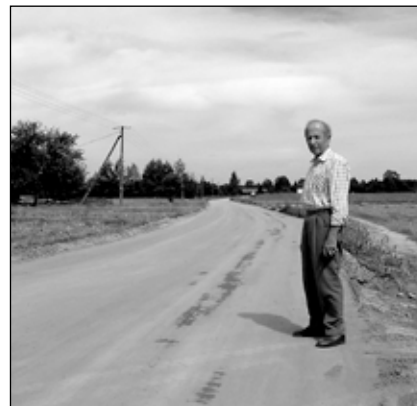
Sołtys wsi Jusaki-Zarzeka Bolesław Piotrowski na budowie drogi.
