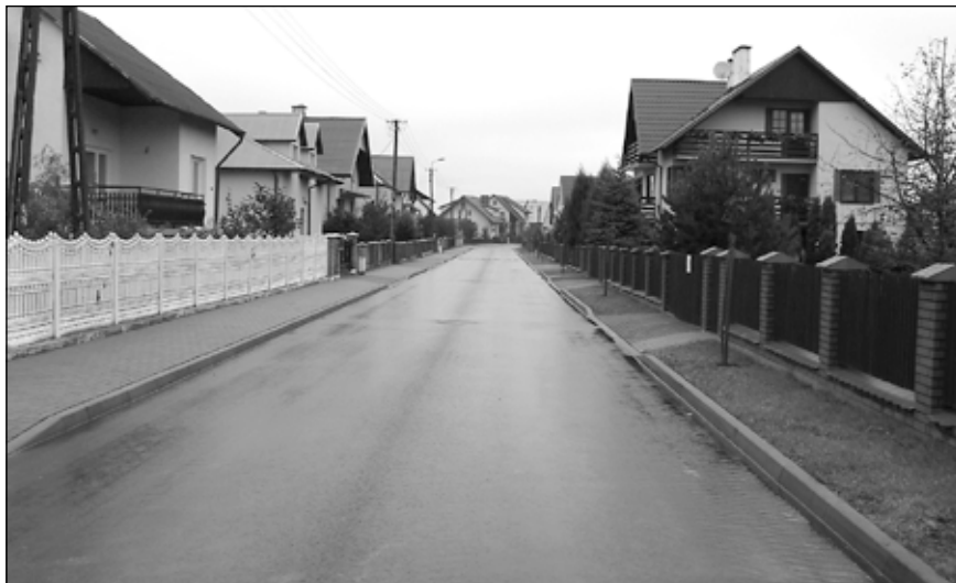
Ulica Parkowa w Konstantynowie po przebudowie 2010 r.
