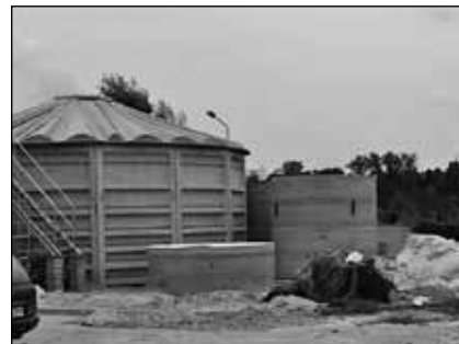
Rozbudowa oczyszczalni ścieków w Piszczacu
