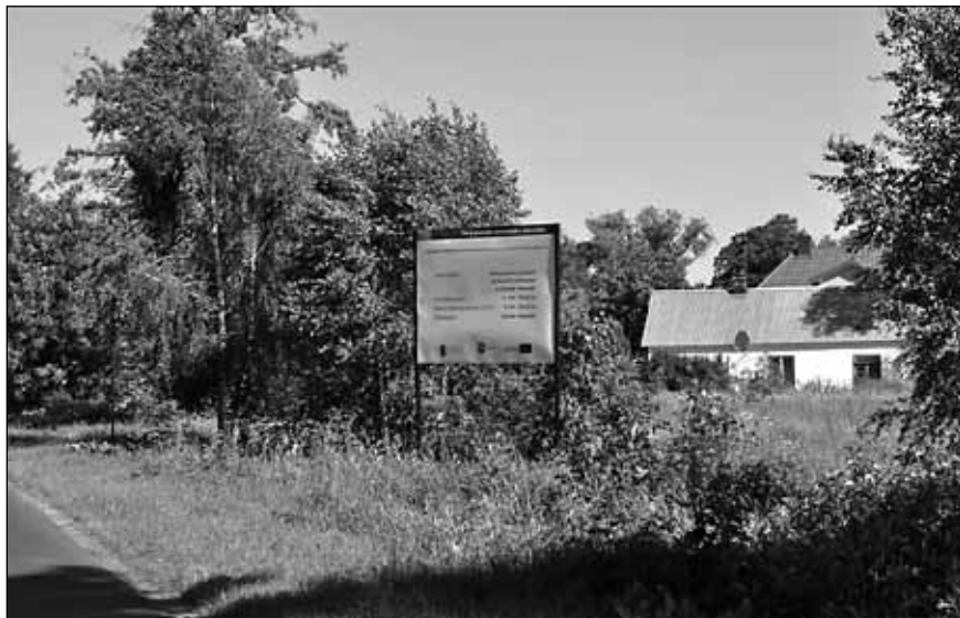
Budowa sieci kanalizacyjnej w Chotyłowie
