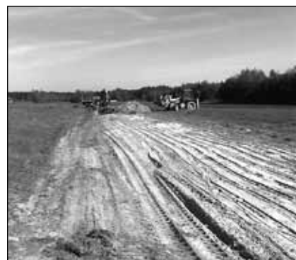
Dobryńka budowa sieci wodociągowej
