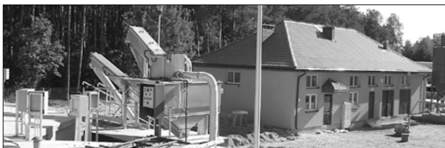
Zmodernizowana i rozbudowana oczyszczalnia ścieków w Wisznicach
