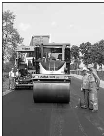
Leśna Podlaska, nowa nawierzchnia asfaltowa
