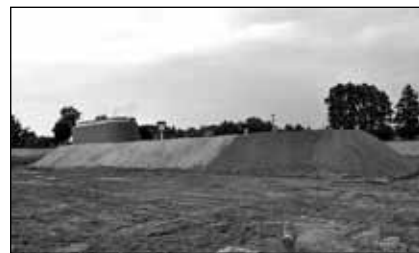
Dąbrowica Mała oczyszczalnia
