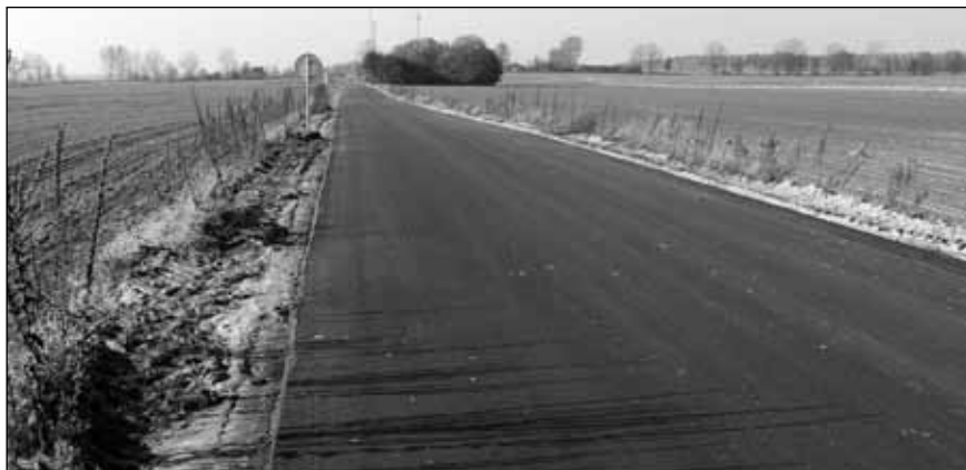
Budowa drogi w miejscowości Witoldów - 2008 r.
