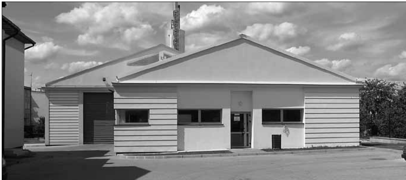
Budowa kotłowni ekologicznej (na słomę) wraz ze składem opał
