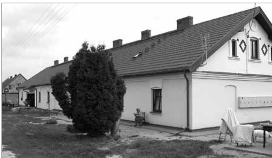
Przebudowa budynku mieszkalnego wielorodzinnego
