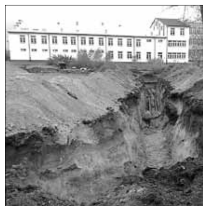
Budowa sieci co do budynków Urzędu Gminy
