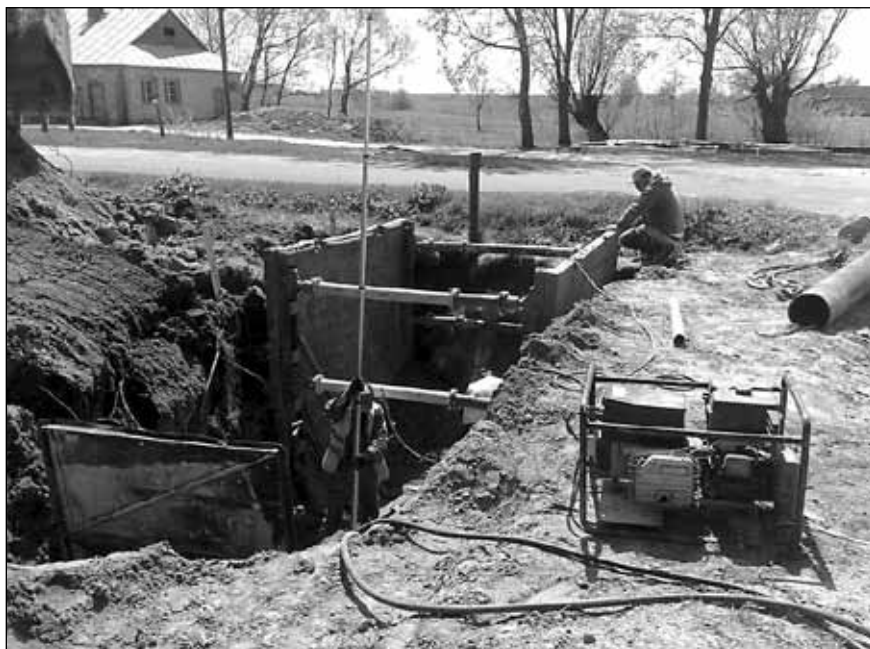
Zahorów - budowa sieci kanalizacyjnej
