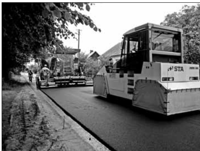
Budowa drogi gminnej Nr 1213 przez wieś Derło
