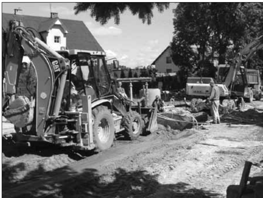
Prace przy budowie kanalizacji w mieście Terespol
