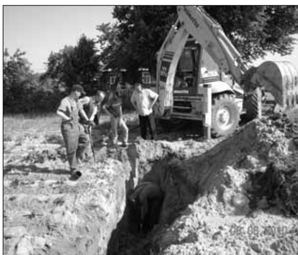
Prace przy rozbudowie sieci wodociągowej na terenie gminy Rokitno
