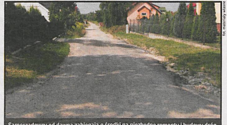
Samorządowcy od dawna zabiegają o środki na niezbędne remonty i budowy dróg
