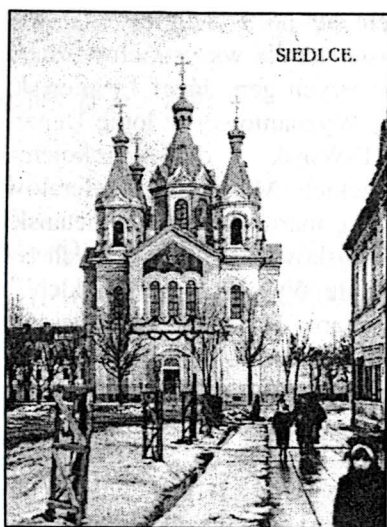
Cerkiew prawosławna w Siedlcach, fot. 1908 r.
