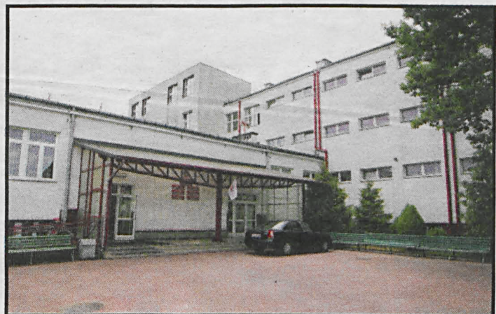
Tuż za budynkiem ZSP zostaną wybudowane nowe warsztaty szkolne
