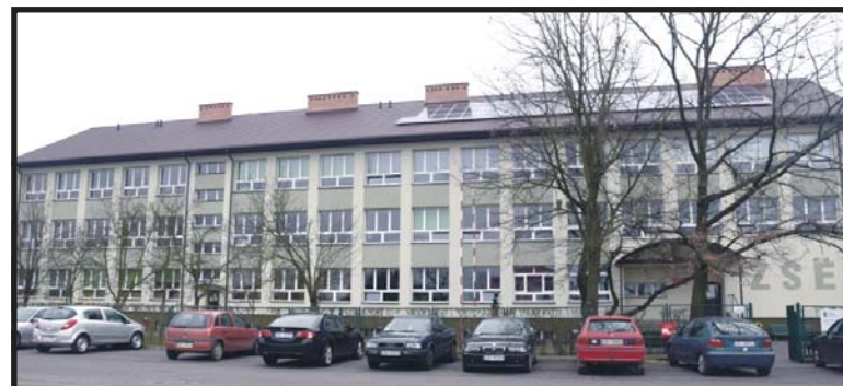
W międzyrzeckim „ekonomiku” m.in. wyremontowano dach, na którym zamontowano instalację fotowoltaiczną
