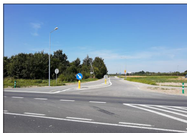
Kolejna ważna inwestycja gotowa
