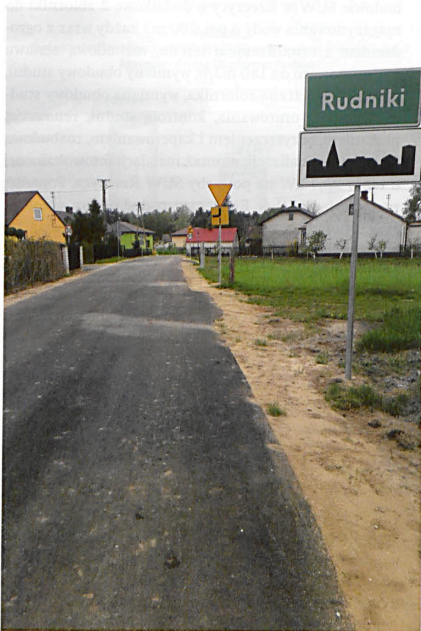
Nowa nawierzchnia asfaltowa na drodze gminnej w Rudnikach
