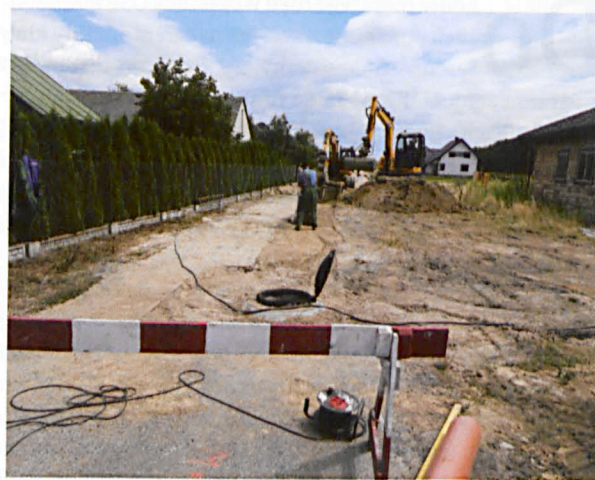
Prace budowlane nad kanalizacją w Rzeczyca
