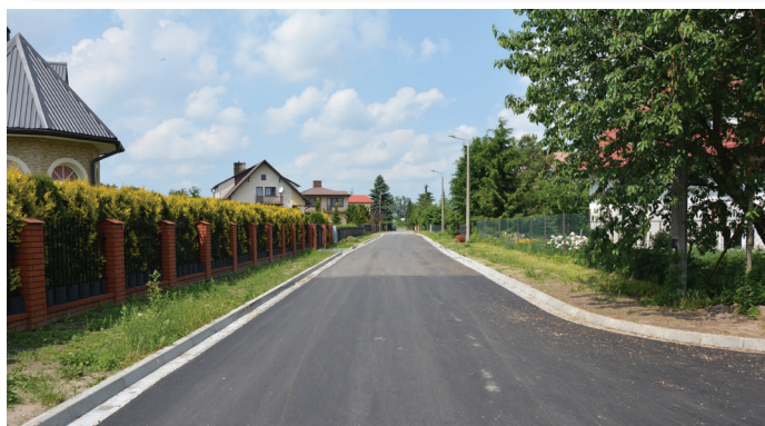
Nowa nawierzchnia na ul. Brzechwy
