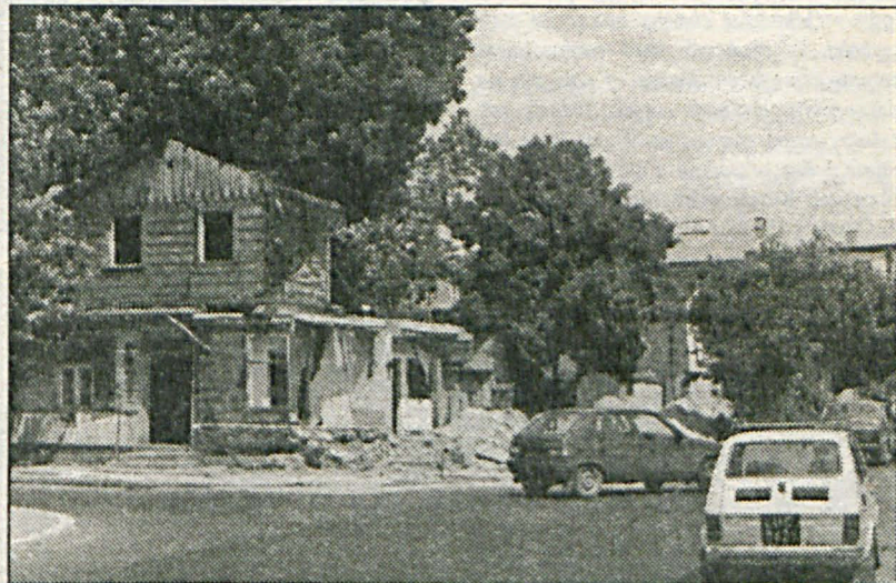
Ul. Narutowicza w Białej Podl. Kolejna rudera trafiła do rozbiórki.
