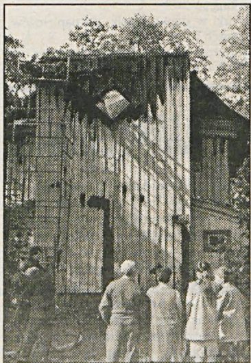
W przeddzień pożaru zakończono prace przy budowie dachu. Pozostały jeszcze rusztowania.
