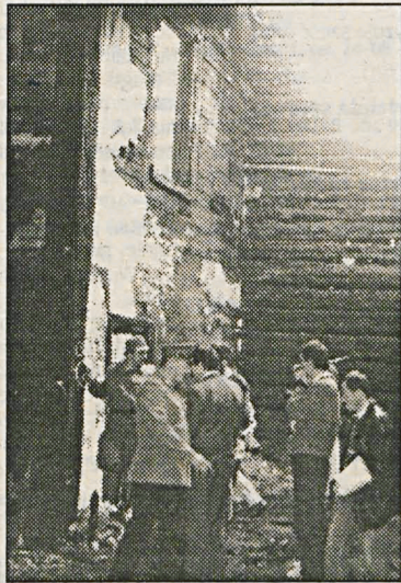
W dymiących jeszcze zgłiszczach rozpoczęła pracę grupa śledcza w celu ustalenia przyczyn pożaru.
