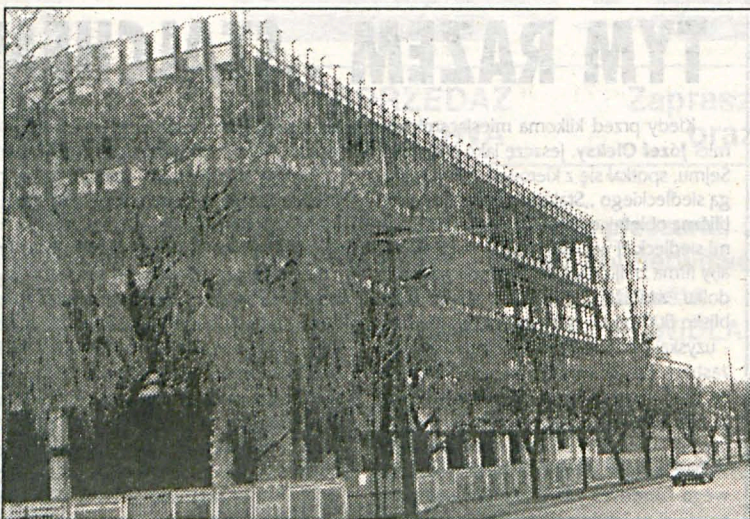
Niegdyś mocna konstrukcja ZPD „Karo” dziś grozi zawaleniem
