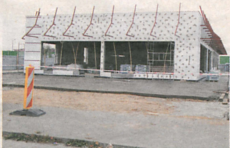
Budowa pierwszej inwestycji McDonald idzie pełną parą
