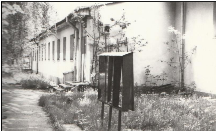
Fotografia 11. Wygląd budynku Nr 17/6046 od strony jednostki z przeznaczeniem na kaplicę. Źródło APK, t. II, b.p.
