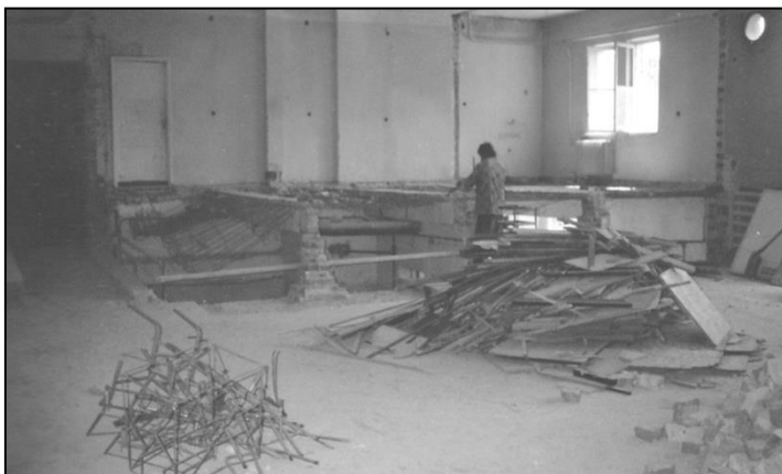
Fotografia 12. Prace przy budowie nowej kaplicy. Źródło APK, t. II, b.p.
