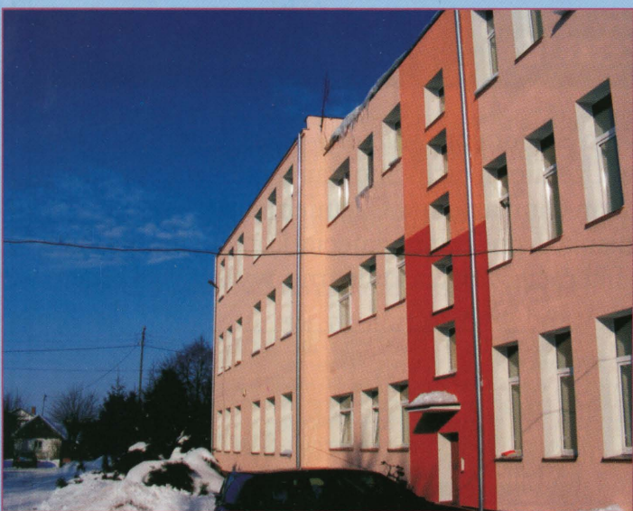
W czasie wakacji wykonano termomodernizację budynku Szkoły Podstawowej
