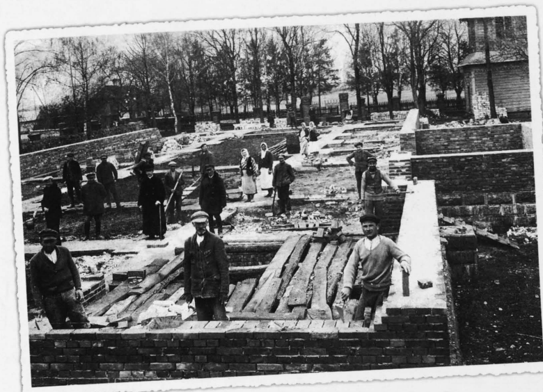
Budowa kościoła lata 1933-1955. Fundamenty położono w 1910 r.
