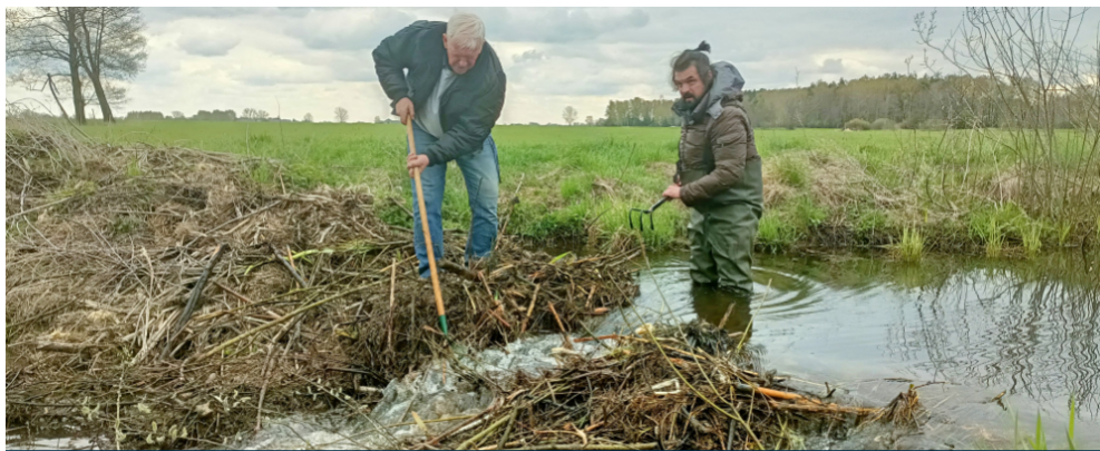
Montaż przepustu typu clemson wykonał właściciel firmy Ekoconsulting Piotr Burgieł
