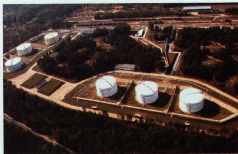
Baza magazynowa paliw w Małaszewiczach
