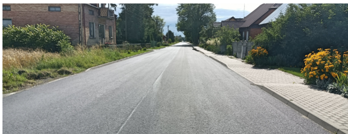
Małobrzeska i Budzyń z nową nawierzchnią asfaltową
