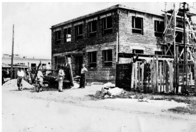
Budowa Piekarni i Kasy Pożyczkowo-Oszczędnościowej lata 60-te
