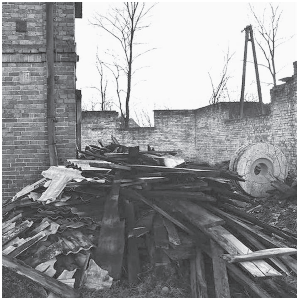
Młyn zbożowy w Sławatyczach – 2015 r (dobudowa zachodnia, w której m.in. tłoczono olej lniany
