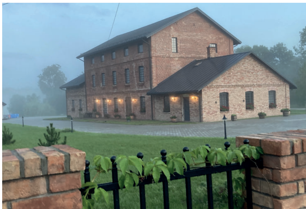
Odrestaurowany budynek młyna zbożowego w Sławatyczach (widok od strony zachodniej dobudowy), 2022 r.
