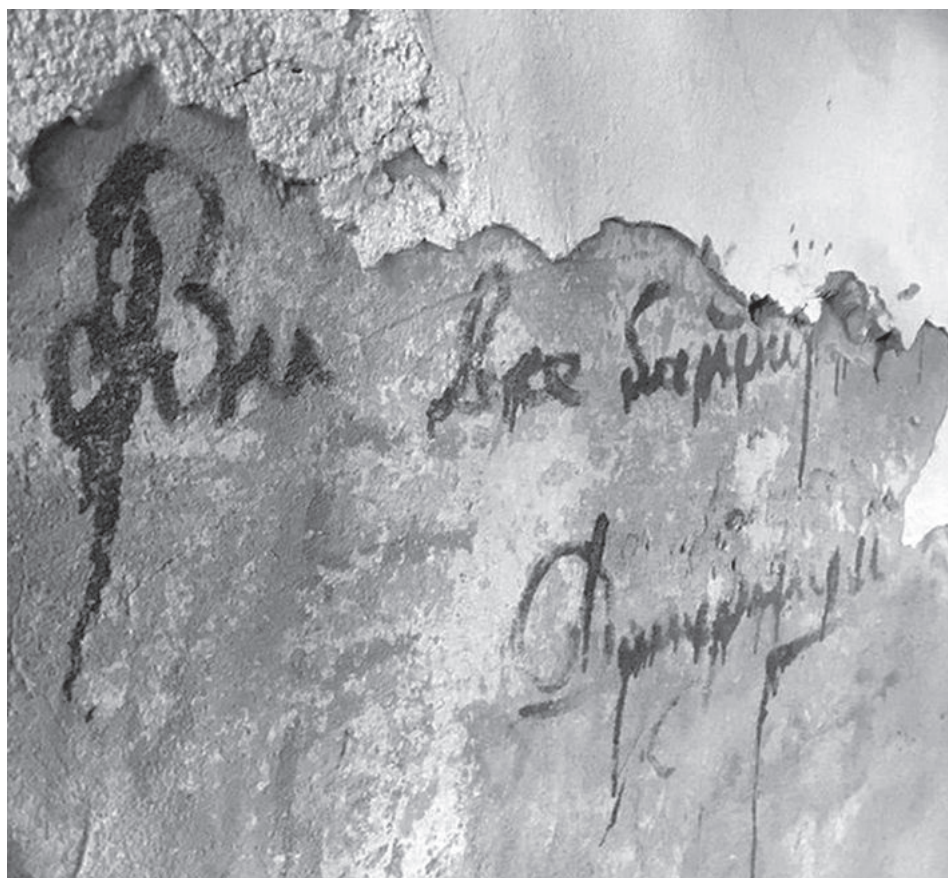
Notatka na ścianie napisana cyrylicą odkryta podczas usuwania starego tynku, 2016 r.
