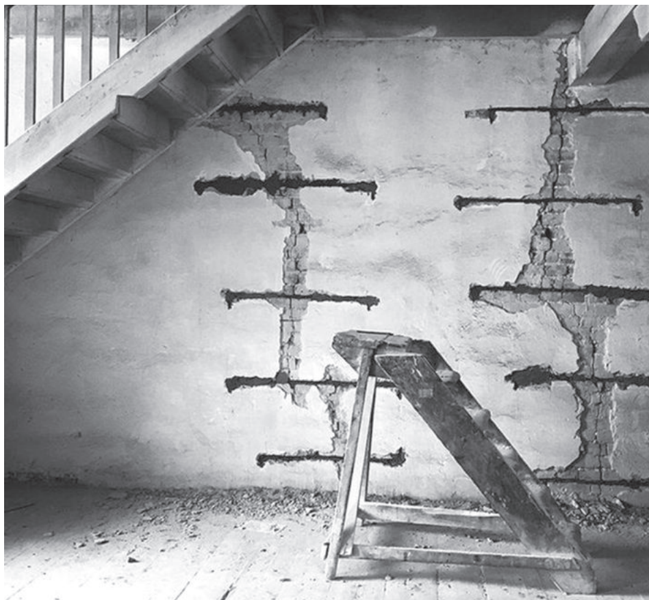
Renowacja ściany wschodniej tzw. szycie ścian, 2017 r.
