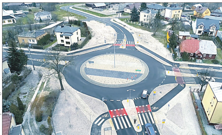
Wybudowanie ronda zapewni większe bezpieczeństwo i pieszych, i zmotoryzowanych
