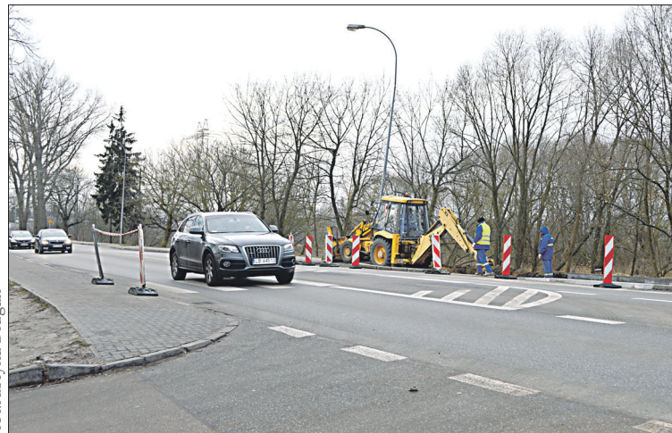
Powstaje między innymi ścieżka rowerowa wzdłuż ulicy Zamkowej
