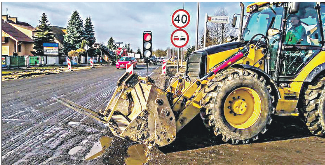
Na odcinku Warszawskiej od skrzyżowania z ulicą Kopernika do posesji nr 65a trwa frezowanie nawierzchni bitumicznej
