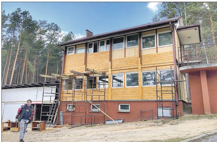
Od kilku tygodni prowadzone są prace remontowo-budowlane w dwóch murowanych obiektach, przeznaczonych do obsługi całorocznej
