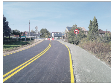
Przygotowana została droga, którą poprowadzony będzie objazd, gdy prace przy tunelu uniemożliwią dotychczasowy przejazd
