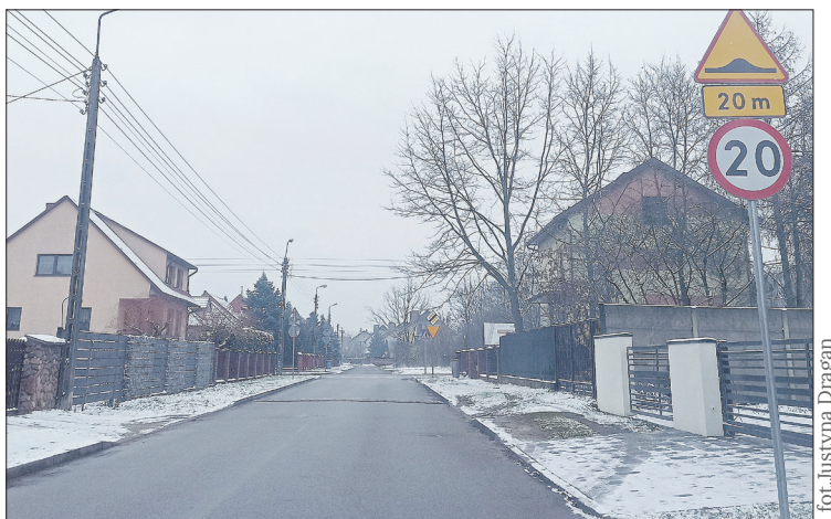
Progi zwalniające poprawiły bezpieczeństwo mieszkańców ul. Wyzwolenia
