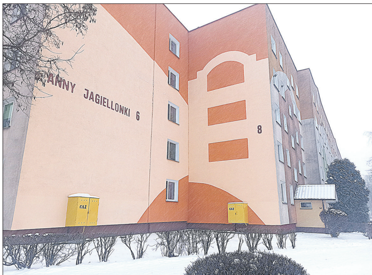
Remont prowadzony w jednym z mieszkań tego bloku bardzo przeszkadza schorowanej kobiecie mieszkającej na parterze
