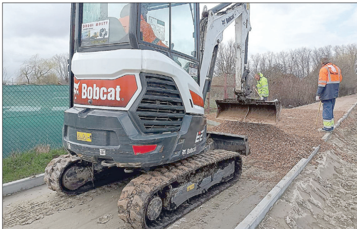
Warunki atmosferyczne sprzyjają, dlatego wykonawca zapowiada zakończenie prac w terminie
