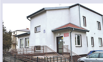
Lokale użytkowe o powierzchni 23,38 m 2 , 19,31 m 2 zlokalizowane na I piętrze budynku przy ul. Stacyjnej 6
