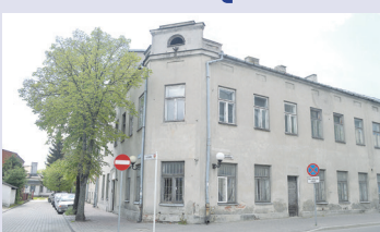
Lokal użytkowy o powierzchni 12,79 m 2 zlokalizowany na I piętrze, przy ul. Krótkiej 1-3
