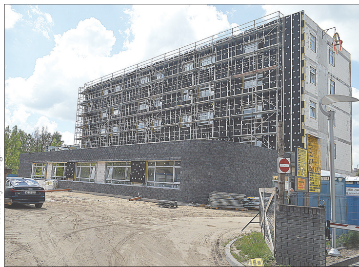
Dom studenta rośnie w oczach, obecnie prowadzone są prace wewnętrzne budynku
