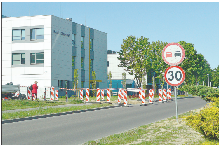
Budowę drogi dojazdowej do Bialskiej Onkologii prowadzi bialska firma PRD
