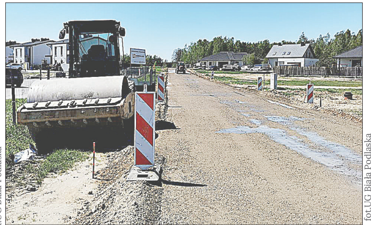
Trwa budowa ponad 2-kilometrowego odcinka drogi pomiędzy Styrzyńcem a Sławacinkiem Starym
