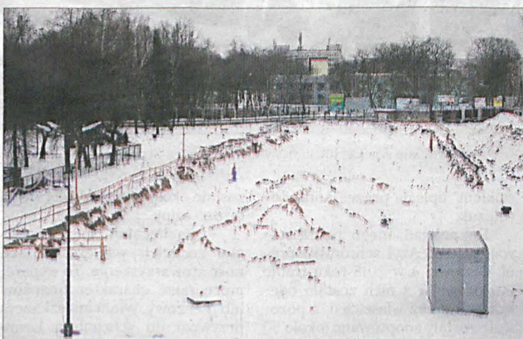
Prace nad budową stadionu stanęły w miejscu, jeszcze zanim nastała zima
