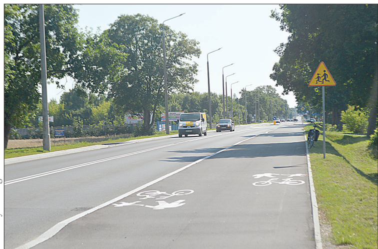
Ulica Warszawska jest już w całości wyremontowana. Ostatni etap dotyczył odcinka od wyjazdu z miasta
