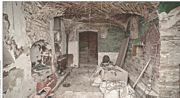
Teraz wykonawca zajmie się uprzątnięciem piwnicy i przygotowaniem do kapitalnego remontu
