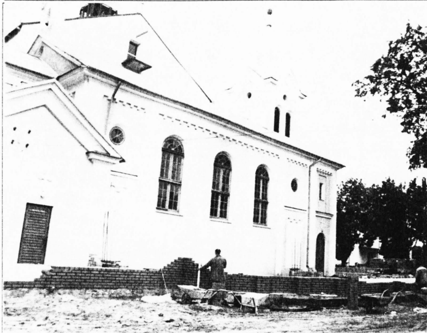
Prace przybudowie nowego prezbiterium.
