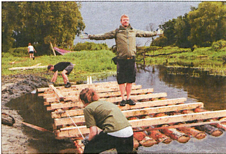
Łukasz Długowski nie tylko nadzorował prace, ale i sam zakasał rękawy i pomagał w budowie
