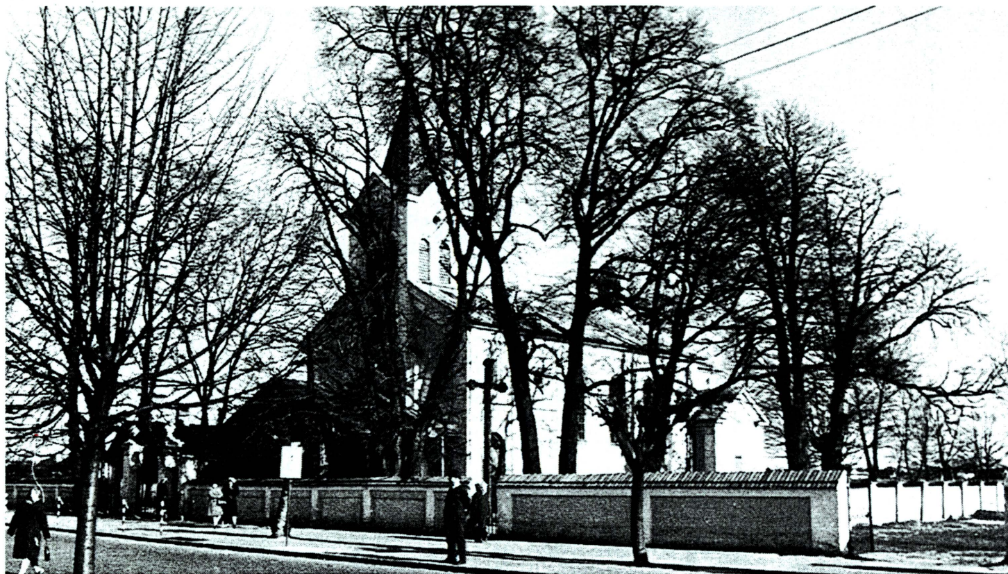
Kościół dominikański w Terespole wybudowany w 1863 roku fot. K. Tarasiuk
