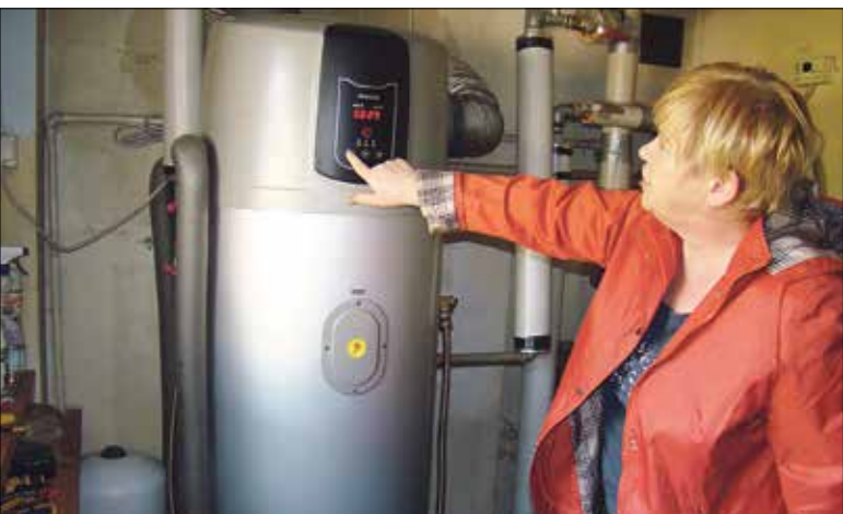
Ledwie zakończony został montaż 451 instalacji związanych z odnawialnymi źródłami energii, a już gmina przyjmuje wnioski mieszkańców do kolejnego projektu, by jesienią powalczyć o jego dofinansowanie. Na zdjęciu Małgorzata Flis z Droblina prezentuje zamontowaną w swoim domu pompę aerotermalną
