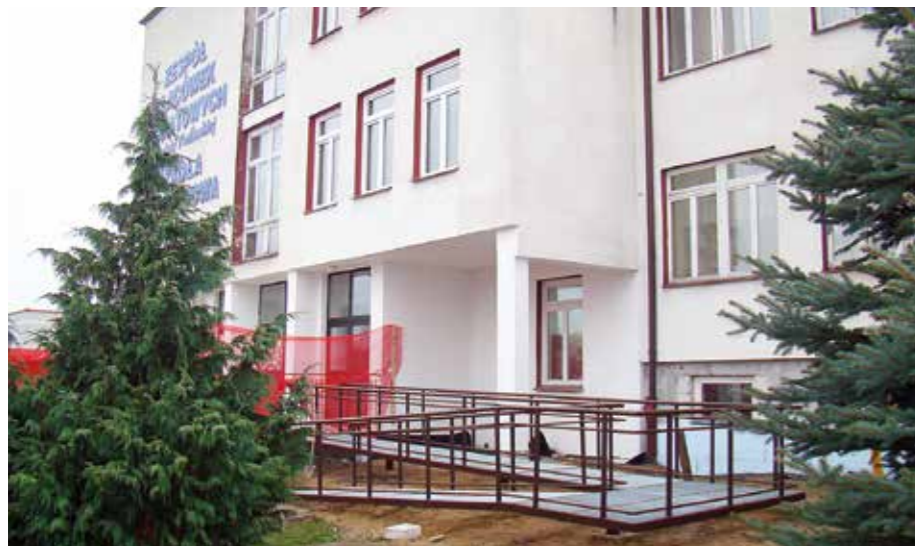
W trzech modernizowanych budynkach, czyli w świetlicy w Witulinie, w Urzędzie Gminy i w szkole wykonane zostaną podjazdy dla niepełnosprawnych
