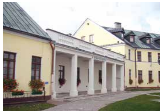
Po modernizacji Domu Pielgrzyma przybędzie dodatkowych 50 miejsc noclegowych
