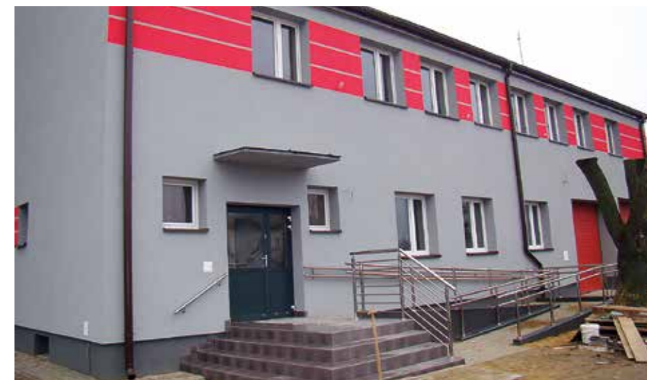
W ramach projektu termomodernizacji budynków użyteczności publicznej ocieplano trzy świetlice wiejskie: w Kolonii Witulin, Witulinie (na zdjęciu) i Nosowie.
