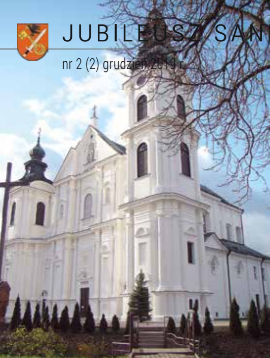
Po odnowieniu elewacji bazylika wygląda bardzo efektywnie
