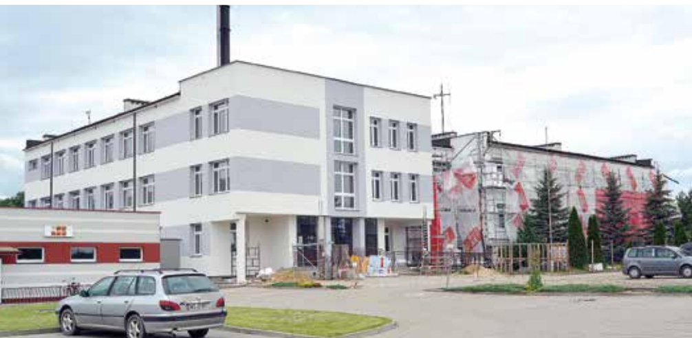
Na szkole zamontowane zostaną panele fotowoltaiczne, a 40-metrowy komin – rozebrany
