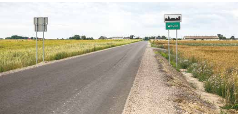
Pierwszy, kilometrowy odcinek drogi Witulin-Witulin Kolonia jest już po odbiorze technicznym
