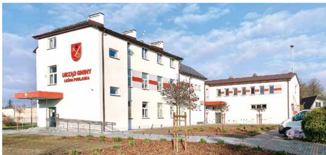
Budynek Urzędu Gminy Leśna Podlaska po termomodernizacji cieszy oko swoim wyglądem, jak i efektywnym otoczeniem
