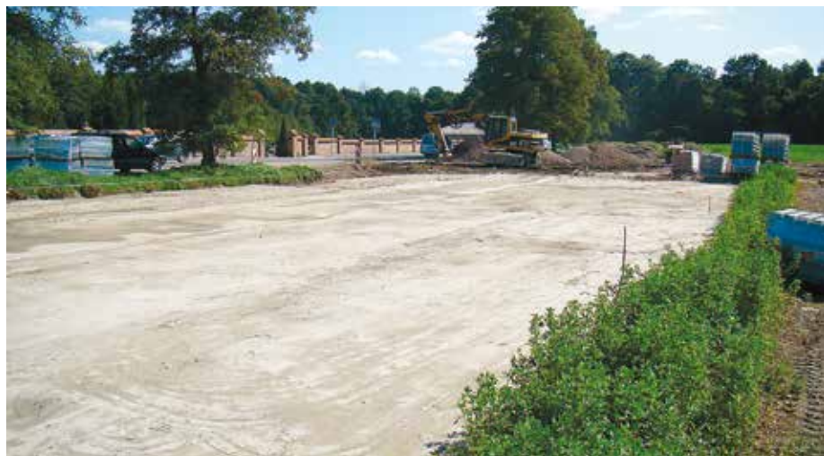
Parking na 50 samochodów powstaje przy cmentarzu w Leśnej Podlaskiej
