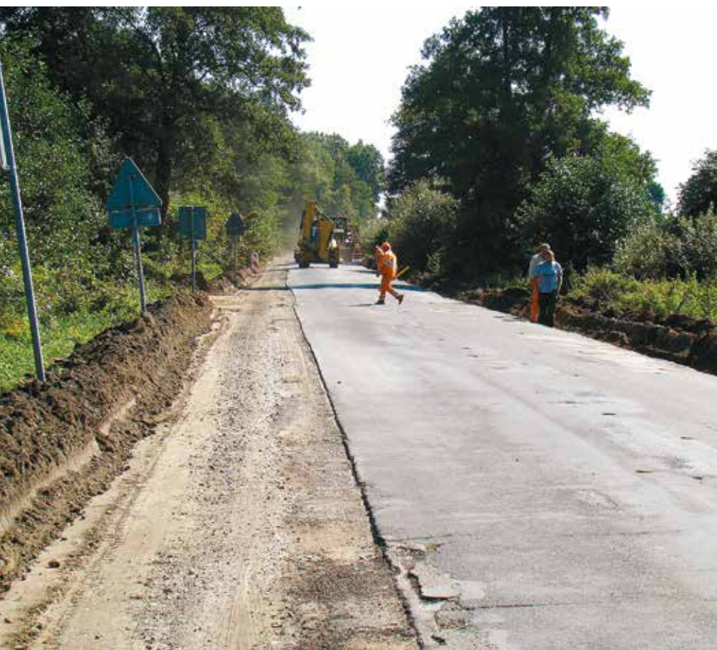
Do połowy listopada będzie wykonany remont nawierzchni drogi powiatowej Leśna Podlaska-Witulina przez rezerwat Chmielinne
