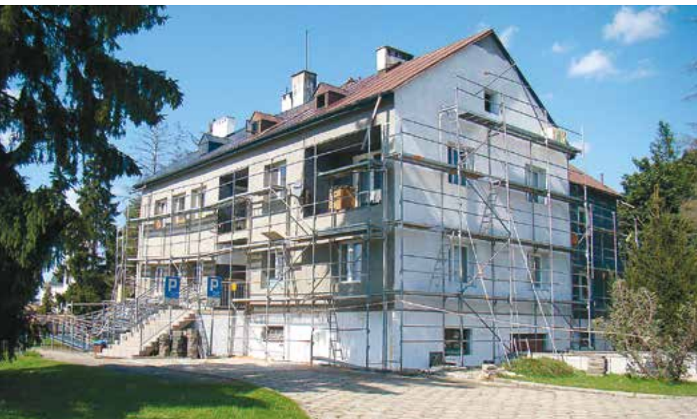
Kontynuowana jest termomodernizacja obiektów użyteczności publicznej. Na zdjęciu ośrodki zdrowia w Leśnej Podlaskiej
