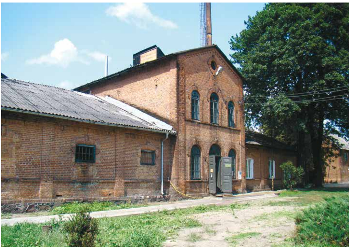
Gorzelnia w Witulinie w murowanym z czerwonej cegły budynku (wcześniej w tym miejscu była drewniana gorzelnia) działa nieprzerwanie od 115 lat
