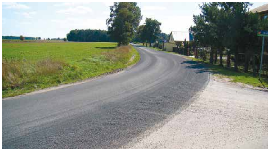
Trwa remont drogi w Starej Bordziłówce
