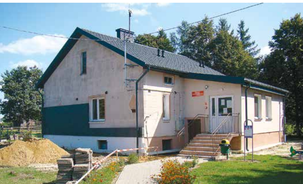
Termomodernizacja budynku Punktu Przedszkolnego w Ossówce
