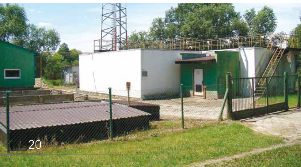
Oczyszczalnię ścieków w Leśnej Podlaskiej czeka w najbliższym czasie gruntowna modernizacja
