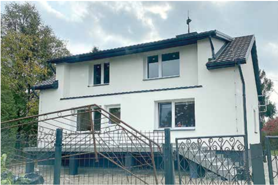
Punkt Przedszkolny w Ossówce został całkowicie odnowiony z zewnątrz, łącznie z wymianą dachu, dociepleniem i pomalowaniem elewacji
