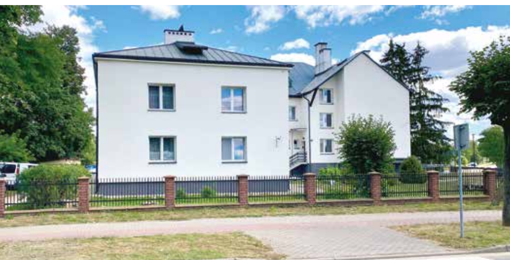
Zakończony został drugi etap termomodernizacji ośrodka zdrowia w Leśnej Podlaskiej
