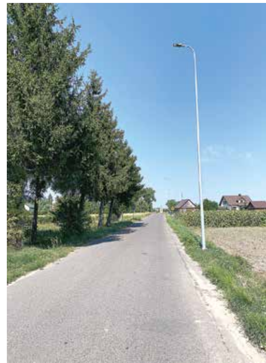
W gminie budowane są nowe tzw. linie wydzielone oświetlenia, czyli takie, które są własnością gminy. Na zdjęciu Bukowice
