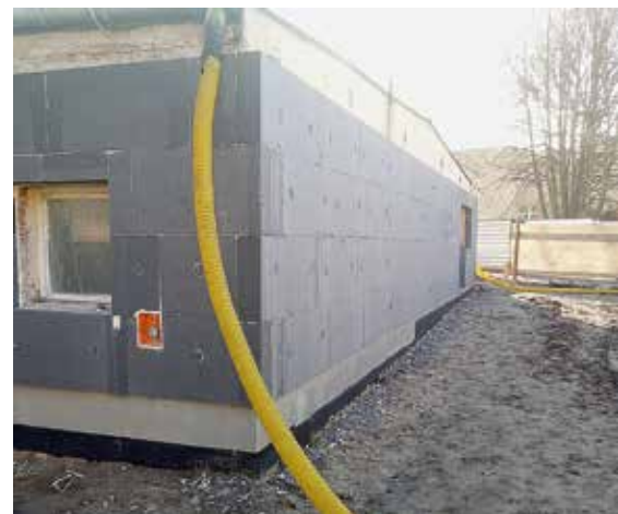
Trwa remont generalny budynku po byłej kotłowni w Piszczacu przy ulicy Spółdzielczej
