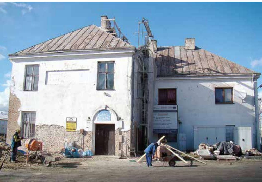
Roboty w dawnej szkole w Piszczacu już się rozpoczęły. Ich zakończenie planowane jest w październiku
